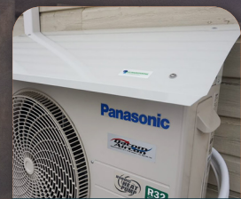
Varmepumpetak
